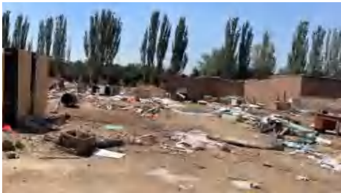
图 4.6-1 地块内残留构筑物垃圾
